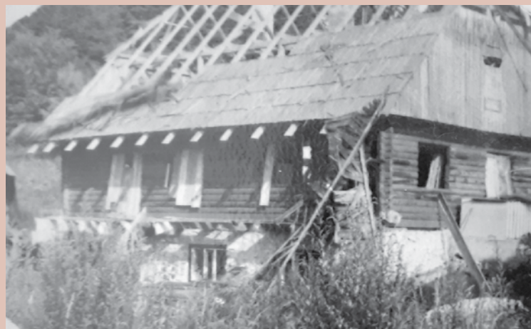
Obnovitvena dela na koči na Kopitniku
